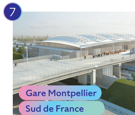
Gare Montpellier Sud de France Architecte : Marc Mimram
